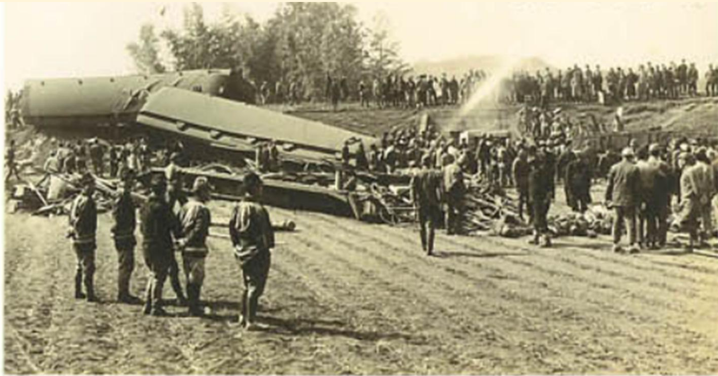
1947. 2. 25の八高線事故現場
