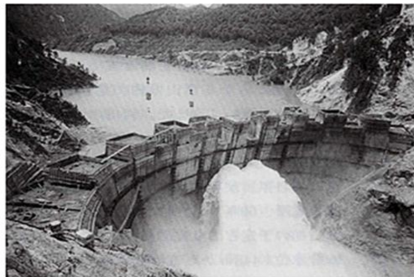
■ 完成前に運用開始された黒部ダム (昭和36年7月2日撮影)
